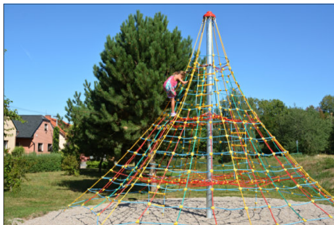
Od 23. července slouží dětem z naší obce i okolí nový herní prvek, lanová pyramida. Ta má výšku 4,5 m a průměr základny 9 m. Materiálem dopadové plochy je kačírek, kterého bylo dovezeno 22 tun. Dodavatelem herního prvku je firma Bonita - Dětská hřiště Tišnov. Snímek z 7.8.2018. (Foto a text J. Pražan)
