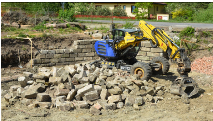
Snímek z výstavby pískovcové opěrné zdi z kvádrového zdiva. (Foto 30.4.2018, J. Pražan)
