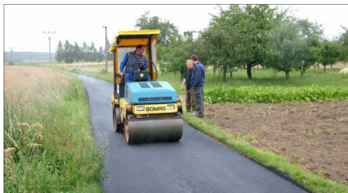
Snímek z 9.8.2018 zachycuje pracovníka firmy M-Silnice Chrudim při hutnění asfaltové obrusné vrstvy na místní komunikaci do Bítovánek. Vpravo, mimo snímek, nemovitost čp. 6. (Foto a text J. Pražan)
