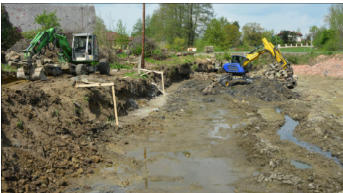
Snímek z výstavby základů opěrné zdi.
