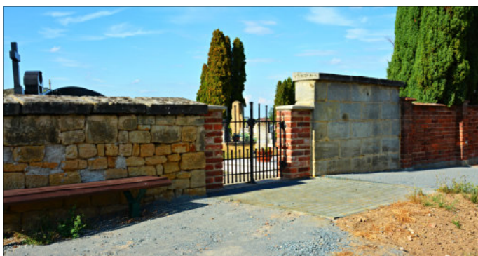
Na snímku z 6.8.2018 je vidět poslední úprava plochy před malou brankou na hřbitově. Malá vydlážděná „plošina“ umožňuje přístup na hřbitov i vozíčkářům. (Foto a text J. Pražan)
