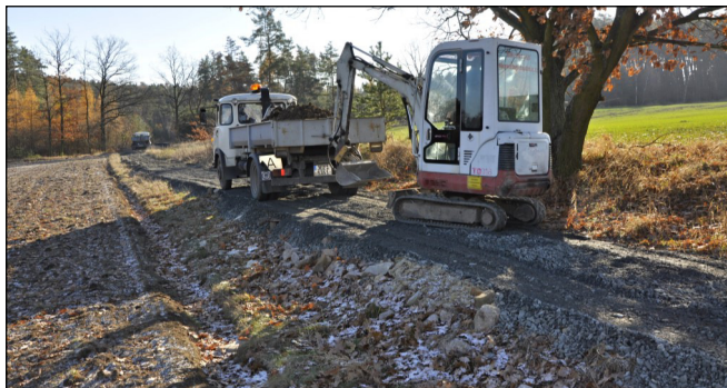
Snímek z 29.11. 2016 je ukázkou toho, jakým způsobem byla cesta k lesu Spálenec opravena. Pro konstrukci podkladní vrstvy bylo využito hrubší kamenivo získané ze zemích prací v obci, kryt cesty tvoří štěrkopísek. O hutnění cestě v takové úpravě povrchu můžeme hovořit jako o cestě mlatové. (Foto a text Pražan)
