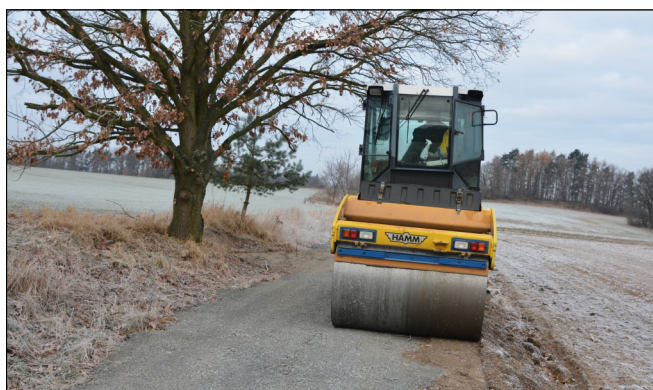
Na snímku z pondělí 13.12. 2016 je zachycen válec firmy M-Silnice při hutnění cesty k lesu Spálenec. (Foto a text Pražan)
