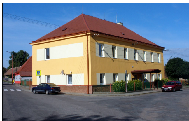
Budova ZŠ v Zaječicích
