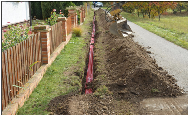
Na snímku z 21.10. 2016 je vidět stav uložení kabelového vedení veřejného osvětlení před jeho zahrnutím zeminou, místo se nachází před č.p. 40.
