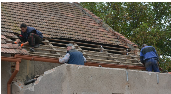
Snímek 23.9.2017 zachycuje hasiče SDH Bítovany při zahájení bouracích prací na přístavku hasičské zbrojnice.
