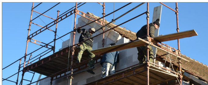
Na snímku z brigády v neděli 10.12.2017 jsou bítovanští hasiči zachyceni při práci na štítu has. zbrojnice. Přidělávají provizorní závětné lišty z prken.
