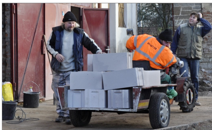
Při sobotní brigádě 9.12.2017 se v rámci prací na rekonstrukci has. zbrojnice naši hasiči podíleli na přísunu materiálu stavební firmě.
