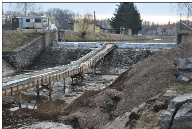
9.3.2015— snímek provizorního dřevěného žlabu (Foto a text Pražan)
