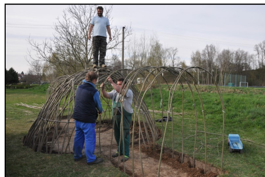
Na snímku ze 17.4.2015 je zachycen postup vyvazování proutů vrbového iglú. Potvrzením toho, že iglú má stabilní konstrukci a dostatečnou pevnost je zatěžovací zkouška, kterou vlastní hmotností provádí osobně pan Jaroslav Kašpárek.
