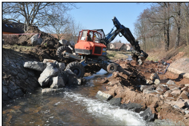
10.3.2015—snímek z opravy dlážděného koryta řeky (Foto a text Pražan)
