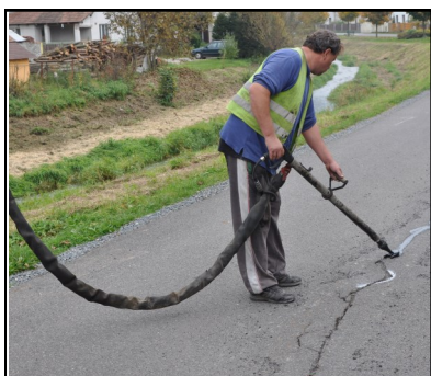
Snímek z 15.10.2013 představuje technologii ošetření trhliny v krytu vozovky zálivkou modifikovaným asfaltem. (Foto Pražan)
