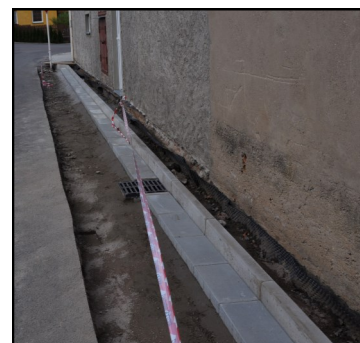
Na snímku z 11.9.2013 jsou vidět obrubníky a vodící proužky osazené do betonového lože. (Foto Pražan)
