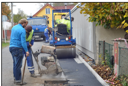
V popředí snímku z 18.10.2013 je vidět stavbyvedoucí firmy M-Silnice Miloš Licek při bourání porušené části krytu komunikace za prodejnou. (Foto Pražan)
