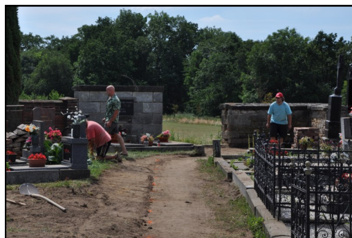
Na snímku z 23.7.2013 jsou zachyceny práce na úpravě plochy pod nový chodník a vzadu vybouraný otvor pro novou branku. (Foto Pražan)
