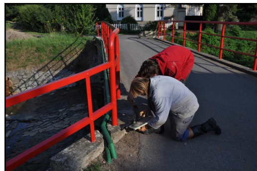
Na snímcích z 31.7. a z 14.8.2013 je vidět horní most. Most prošel pečlivou údržbou, kterou provedli otec a syn Jůnové.
