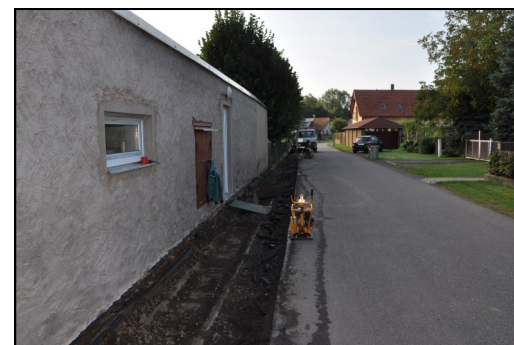
Snímek z 5.9.2013 dokladuje stav prací na opravě komunikace za prodejnou a zahradou MŠ. (Foto Pražan)
