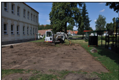
Ve čtvrtek 1.8.2013 byly odstraněny dřevo a podomíči zahájeny zemní práce na zahradě MŠ jako příprava na instalaci nových herních prvků. (Foto Pražan)
