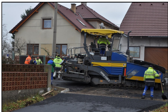
Snímek z 30.11.2012 představuje firmu M-Silnice Chrudim při pokládání ložné vrstvy z asfaltového betonu finišerem před č.p.4 (Foto J. Pražanová)
