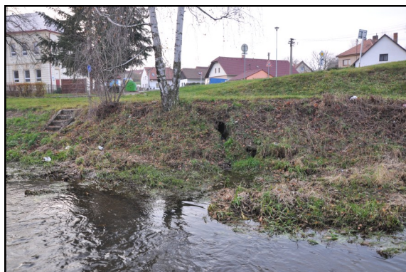
Na snímku z 18.11.2012 je výpust' do řeky v místě „Pod Školou“; zvláště v letních měsících je zjevné, že někde v trase této kanalizace je odpadní voda vypouštěna bez předchozího přefiltrování (Foto J. Pražan)
